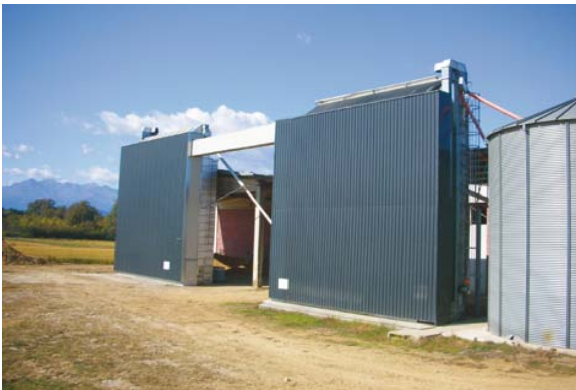
Fig. 8 - I prototipi di essiccatoi ibridi (solare/gasolio) realizzati nell'ambito del progetto RSN con due modalità di asportazione dell'umidità: per insufflaggio (prototipo a destra della foto) o per depressione (a sinistra).
